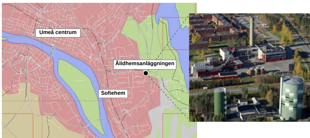
Figur 18. Ålidhemsanläggningen (svart punkt) ligger i sydöstra Umeå och är ett värmeverk med fem pannor som eldar biomassa, torv och olja. Skorstenshöjden är 62 m och merparten av förbränningen sker under vinterhalvåret (flygfoto från Umeå Energi).
